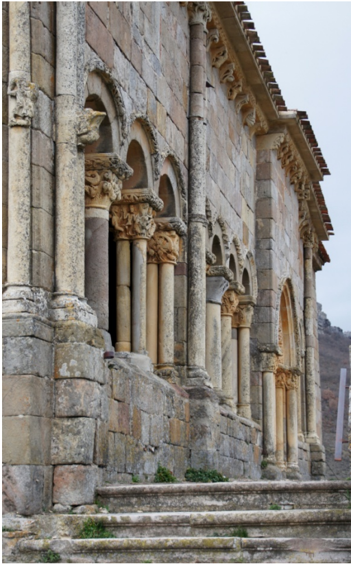
Iglesia de San Juan y Santa Basilisa (Rebolledo de la Torre). Galería porticada s. XII
