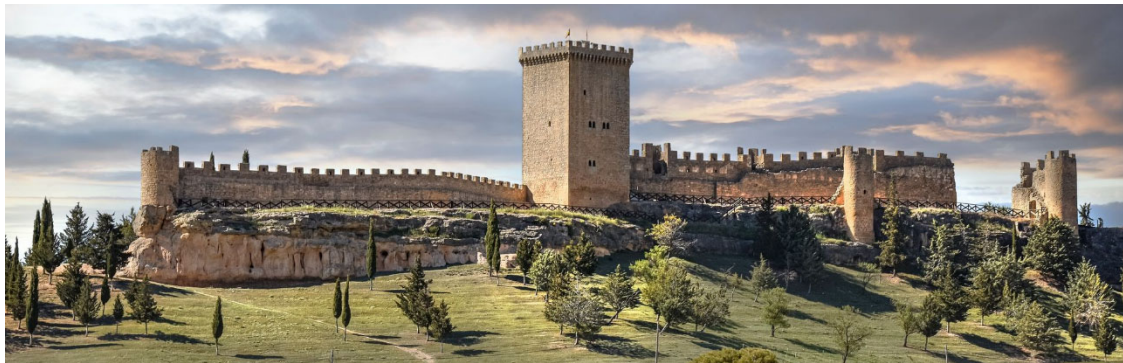
Panorámica Castillo de Peñaranda de Duero y Torre del Homenaje.
