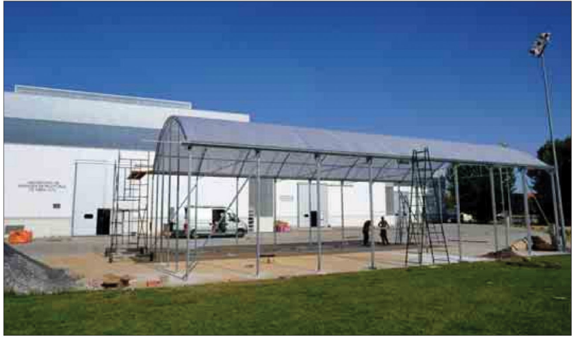
Los trabajos para instalar el invernadero tipo túnel ya han comenzado. / ISRAEL L. MURILLO
